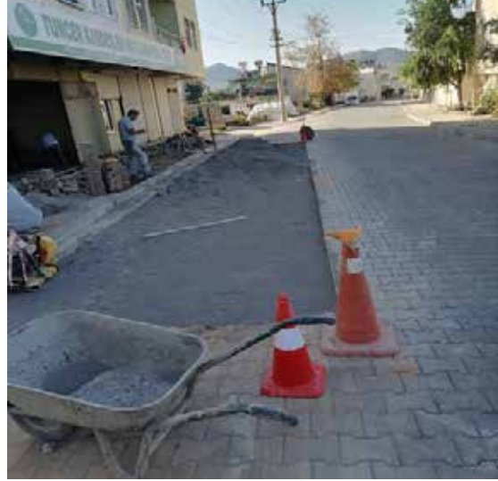
Aydın Mahallesi Yol Tamirâtı Yapımı
