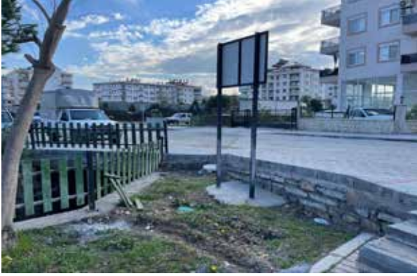
İstiklal Mahallesi Köprü yapımı
