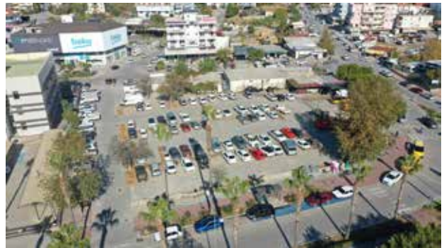
Otopark Yapım İş (Sonrası)
