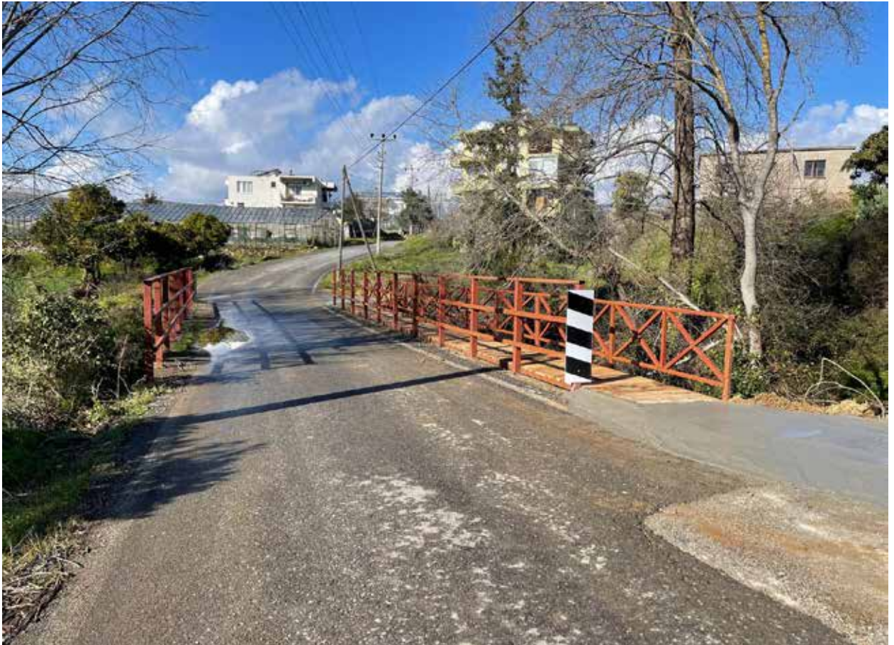
Macar Mahallesi Köprü ve Korkuluk yapımı
