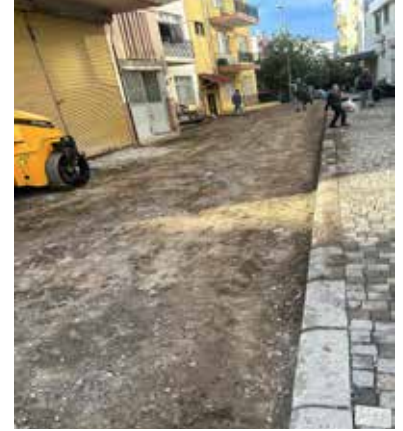
İstiklal Mahallesi Parke Yol Yapımı
