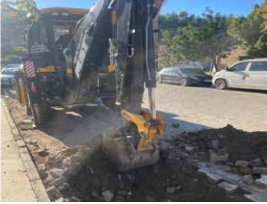
Sanayi Sitesi yağmur suyu hattı yapımı
