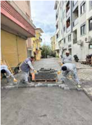
İstiklal Mahallesi parke yol yapımı
