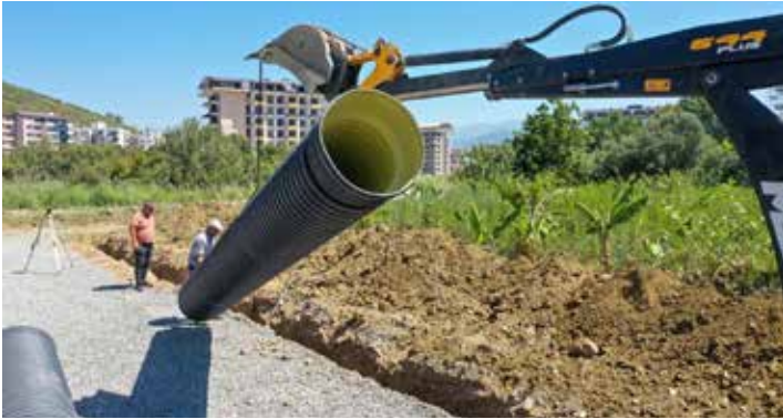
Sanayi Sitesi yağmur suyu hattı yapımı
