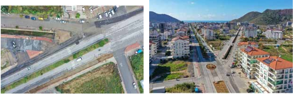
Pazarcı Mahallesi.Yapımı tamamlanan Kavşak çalışması.
