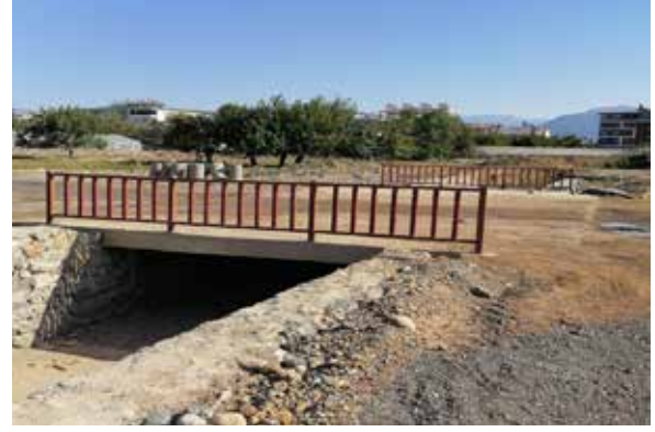
Yeni Mahalle Köprü yapımı
